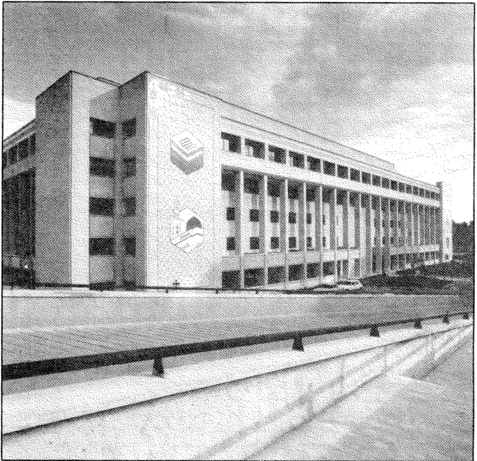
نمای شمال غربی ساختمان از روی راسب درب شمالی.
